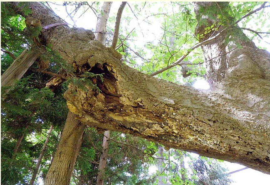
主幹部と分岐した太枝の腐朽部です
