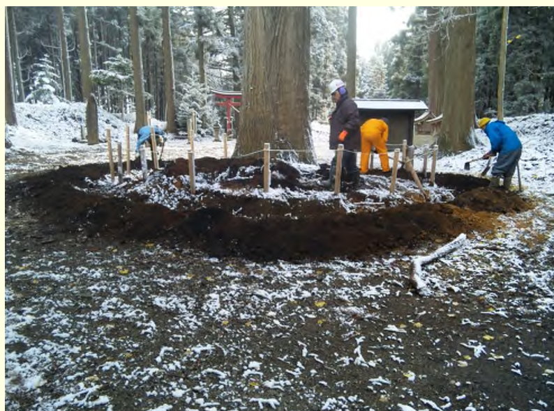
土壌改良工実施中
