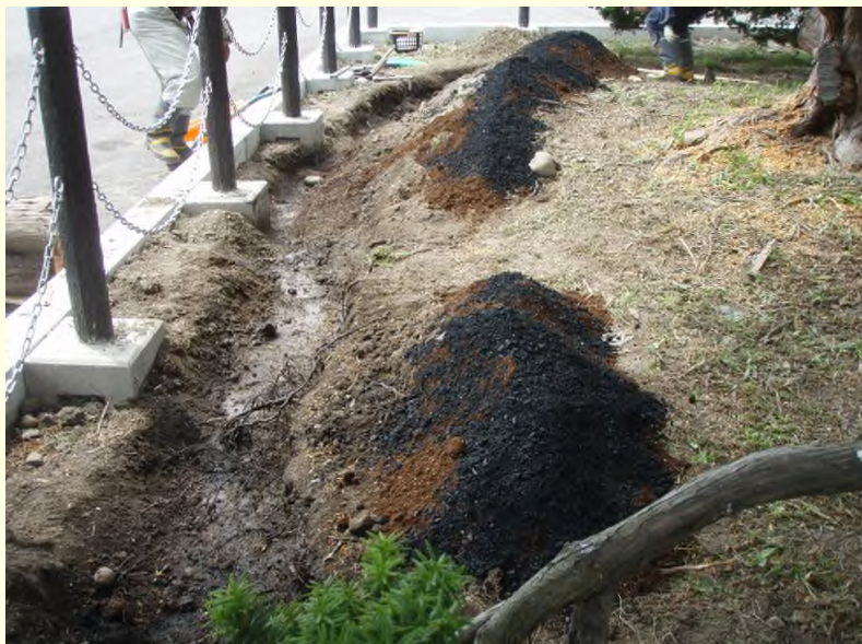
土壌改良工実施中
