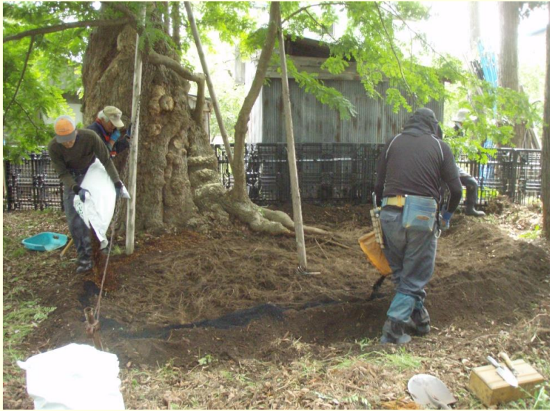
土壌改良工 活性炭の混合
